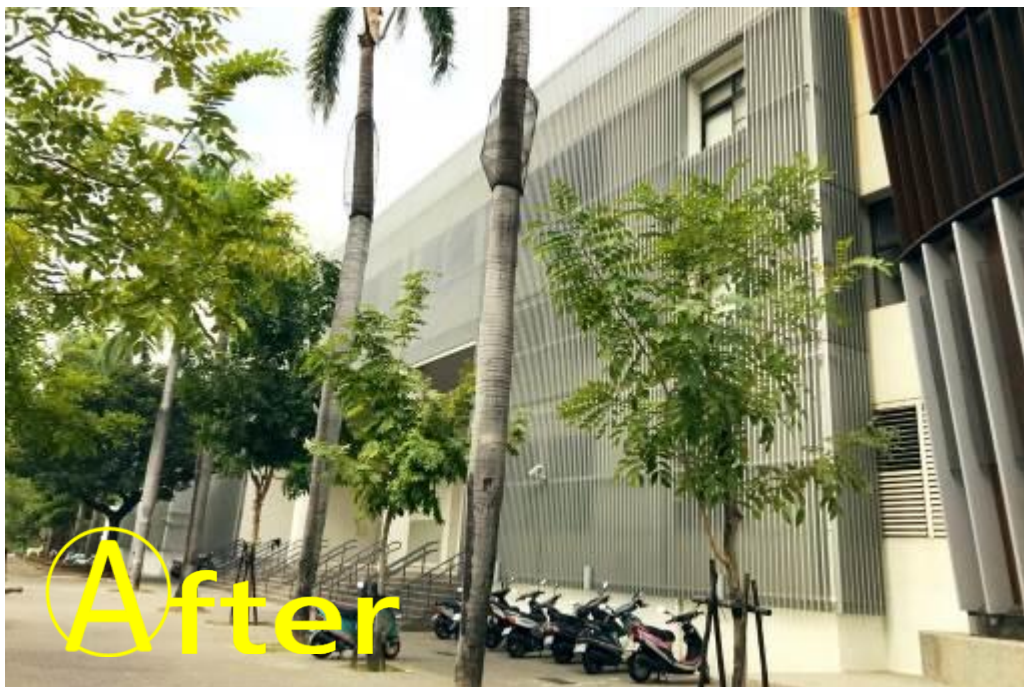
整修後演藝廳南側景觀-融合整體建築設計風格，映造周遭綠意
