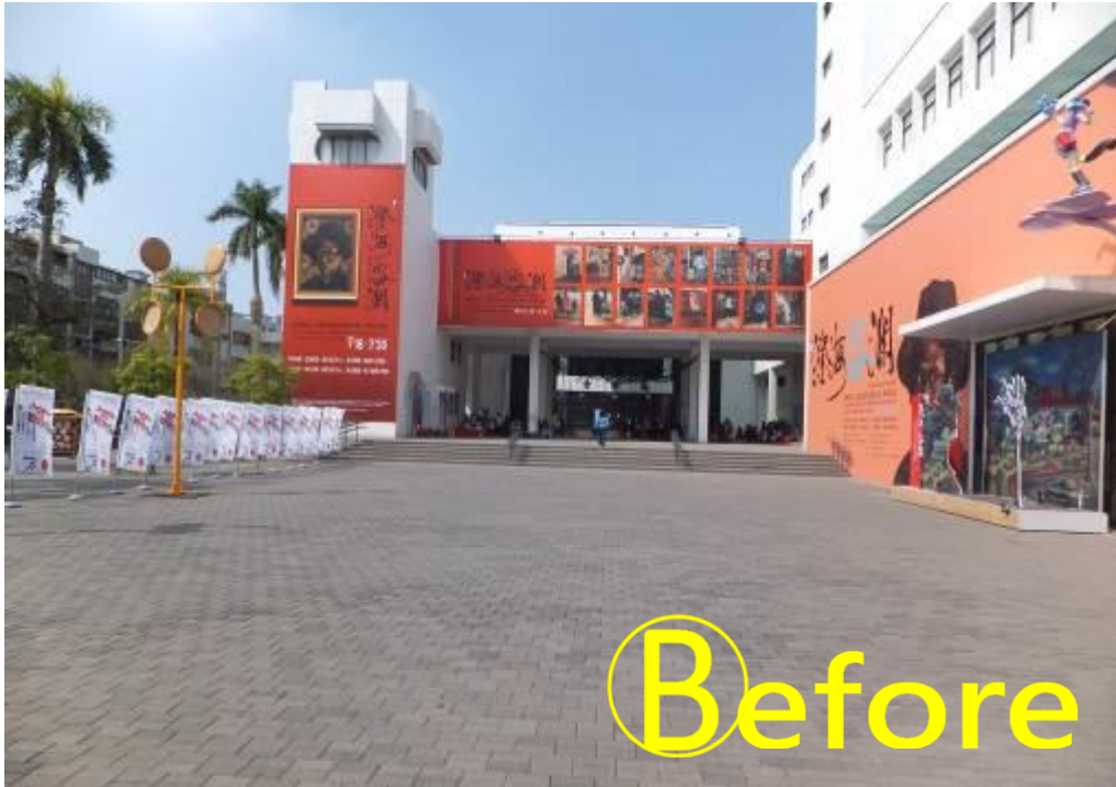
整修前演藝廳外觀及廣場-景色單調且無提供停駐休憩空間
